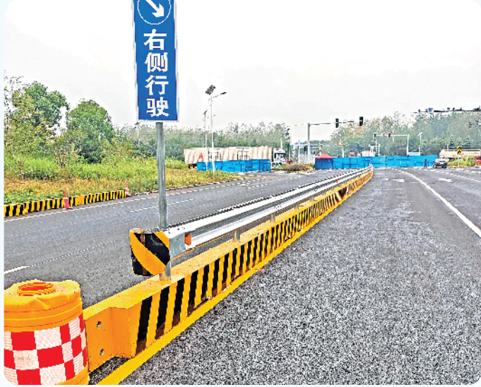
完成修复养护的国道。 通讯员 孙海兴 尤光辉 摄
