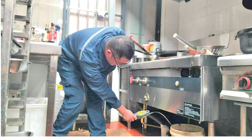
安检员对商户厨房进行安全检查。徐州港华燃气 供图
