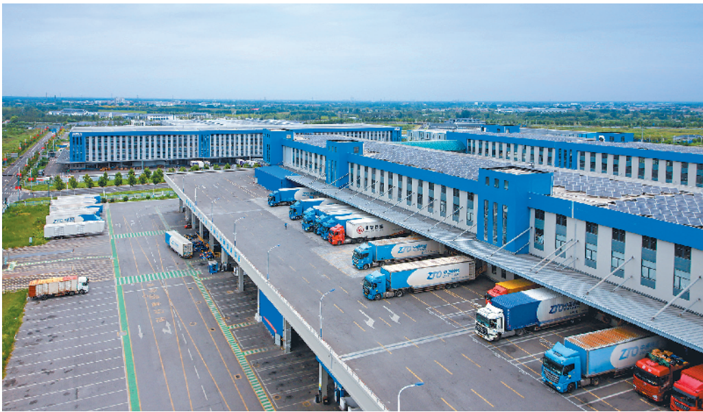
中通快递区域总部项目。本报记者 张荏衍 摄
