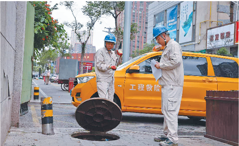
施工人员加紧施工，保障今冬供暖。 本报记者 田镭玮 许晨 摄
