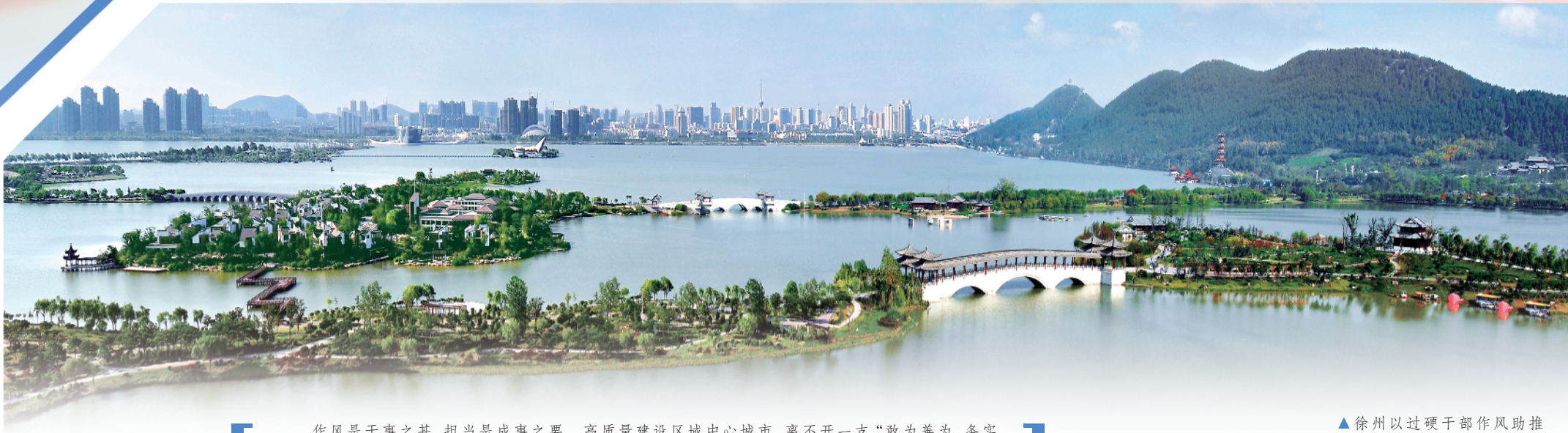
▲徐州以过硬干部作风助推现代化区域中心城市建设。
