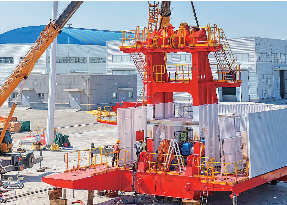
动式门座式起重机的安装。吨级泊位，设计年通过能力94万吨，年吞吐量88万吨。图为工人们正在进行徐州港顺堤河作业区二期码头工程总投资约18亿元，规划建设12个2000
