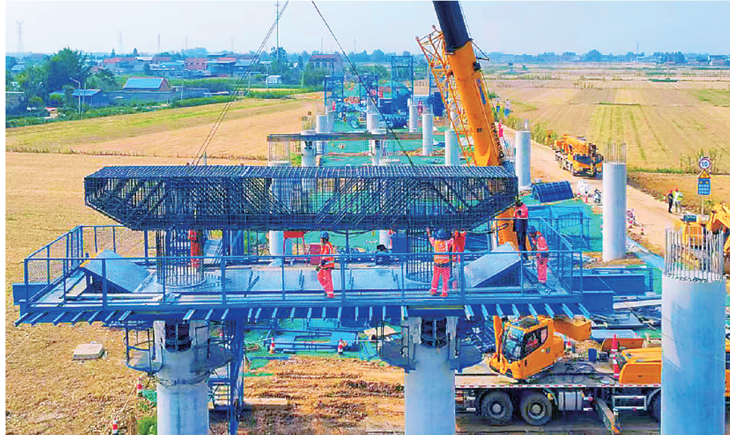
台睢高速京杭运河特大桥施工中。 通讯员 孙宁 摄
