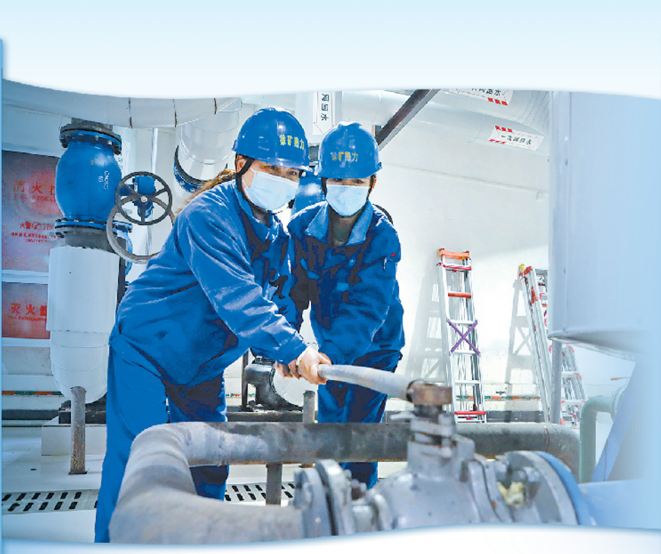
▲ 供热管网提升改造。 市住建局 供图
