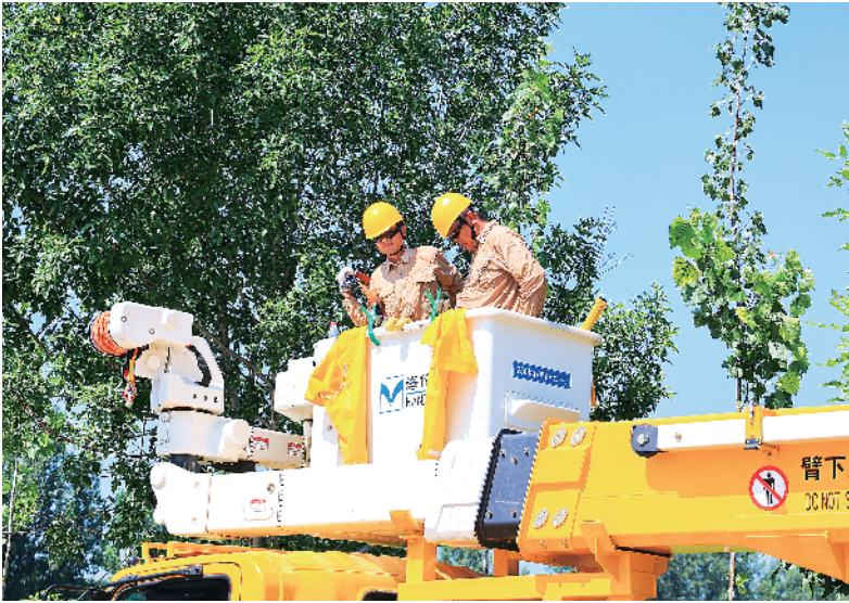
国网沛县供电公司组织带电作业人员在10kV 胡南108线43-2+1号杆进行带负荷加装柱上开关工作。 国网徐州供电公司 供图
