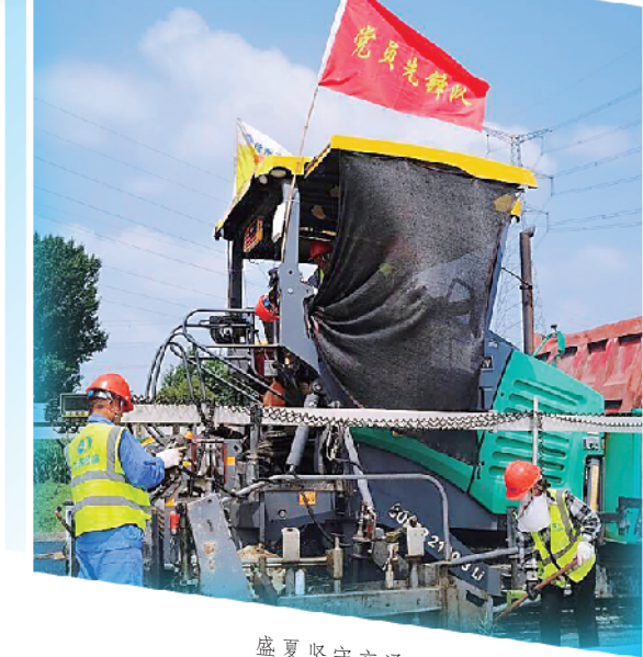
盛夏坚守交通重点工程施工岗位。
