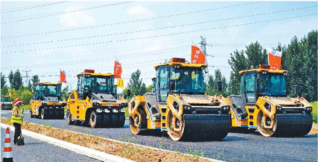
徐州外环公路（西南环）项目路面施工现场。本报记者 杨济博 实习生 刘熙琳 摄
