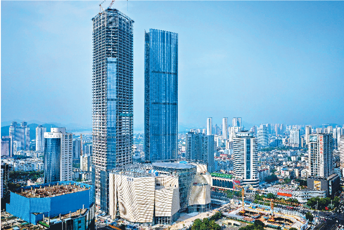
楼施工,确保城市新地标如期落成。
