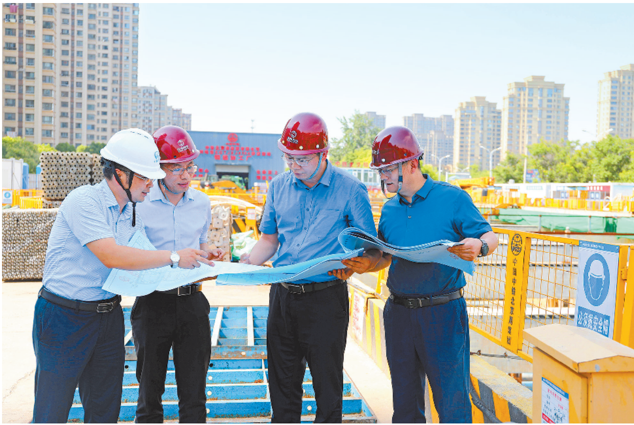
尹鹏程（右二）到工地现场察看施工情况。
