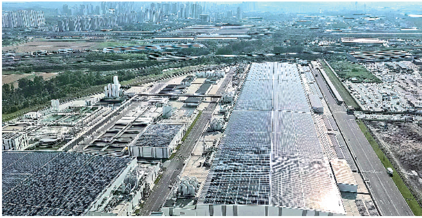
35.4MW 屋顶光伏项目为企业打造零碳厂区。受访单位 供图
