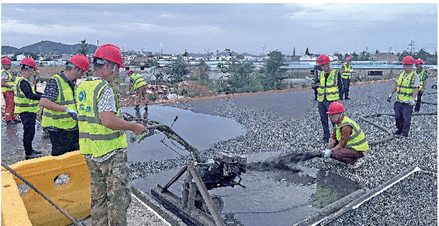
新型路面工艺施工现场。 通讯员 杨湘明 摄
