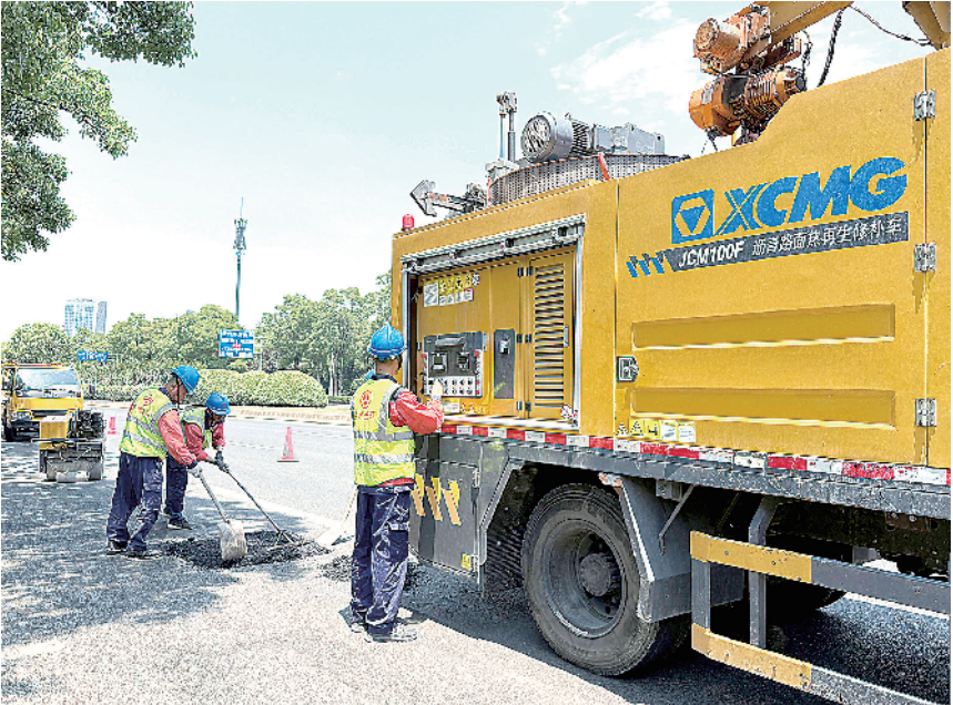
沥青路面热再生车修补坑槽。 通讯员 黄欣 尤光辉 摄
