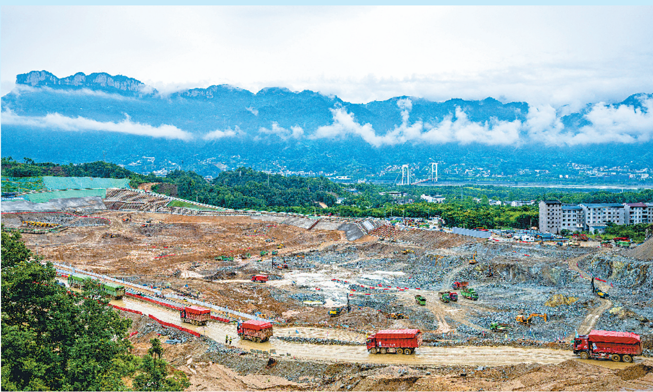
6月8日拍摄的三峡水运新通道工程先行开挖区施工现场。
