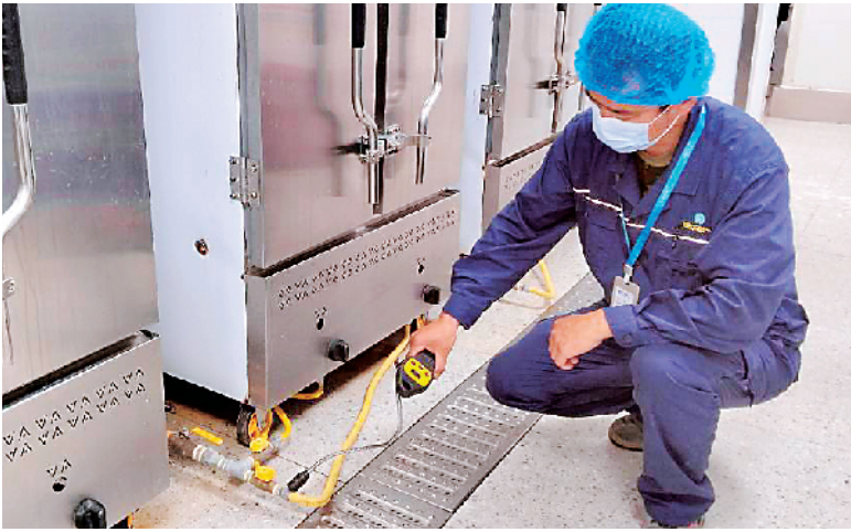
检查。工作人员对厨房灶具连接管进行安全
