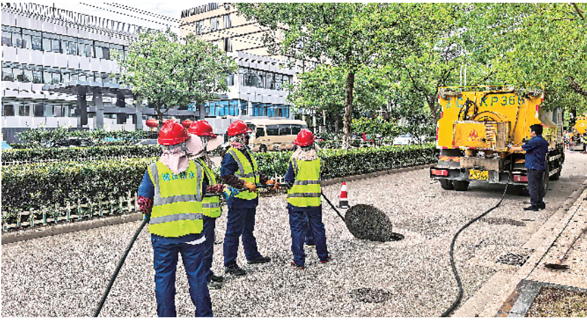
养护工人进行管网疏通。 本报记者 魏欣 摄
