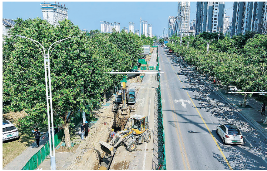
海河路施工现场。 本报记者 黄扬 摄
