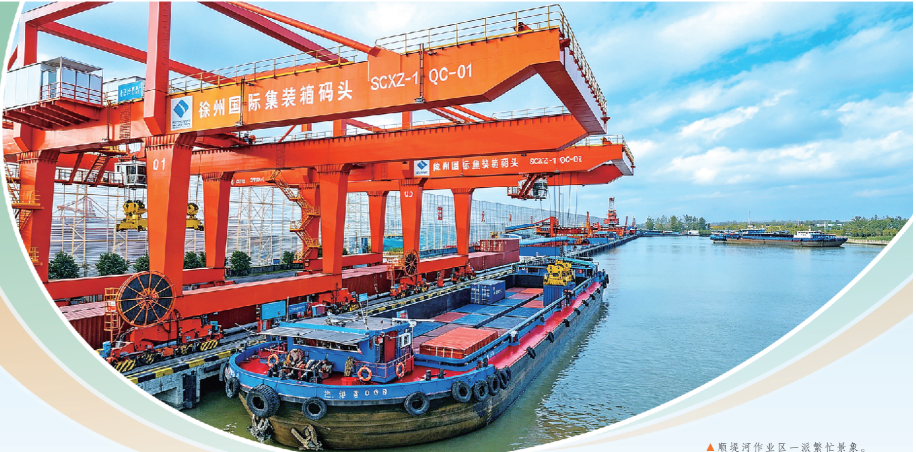
▲顺堤河作业区一派繁忙景象。
