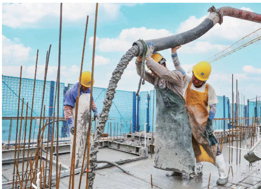
徐矿城西定销房施工现场一片忙碌景象。 本报记者 吴国乐摄
