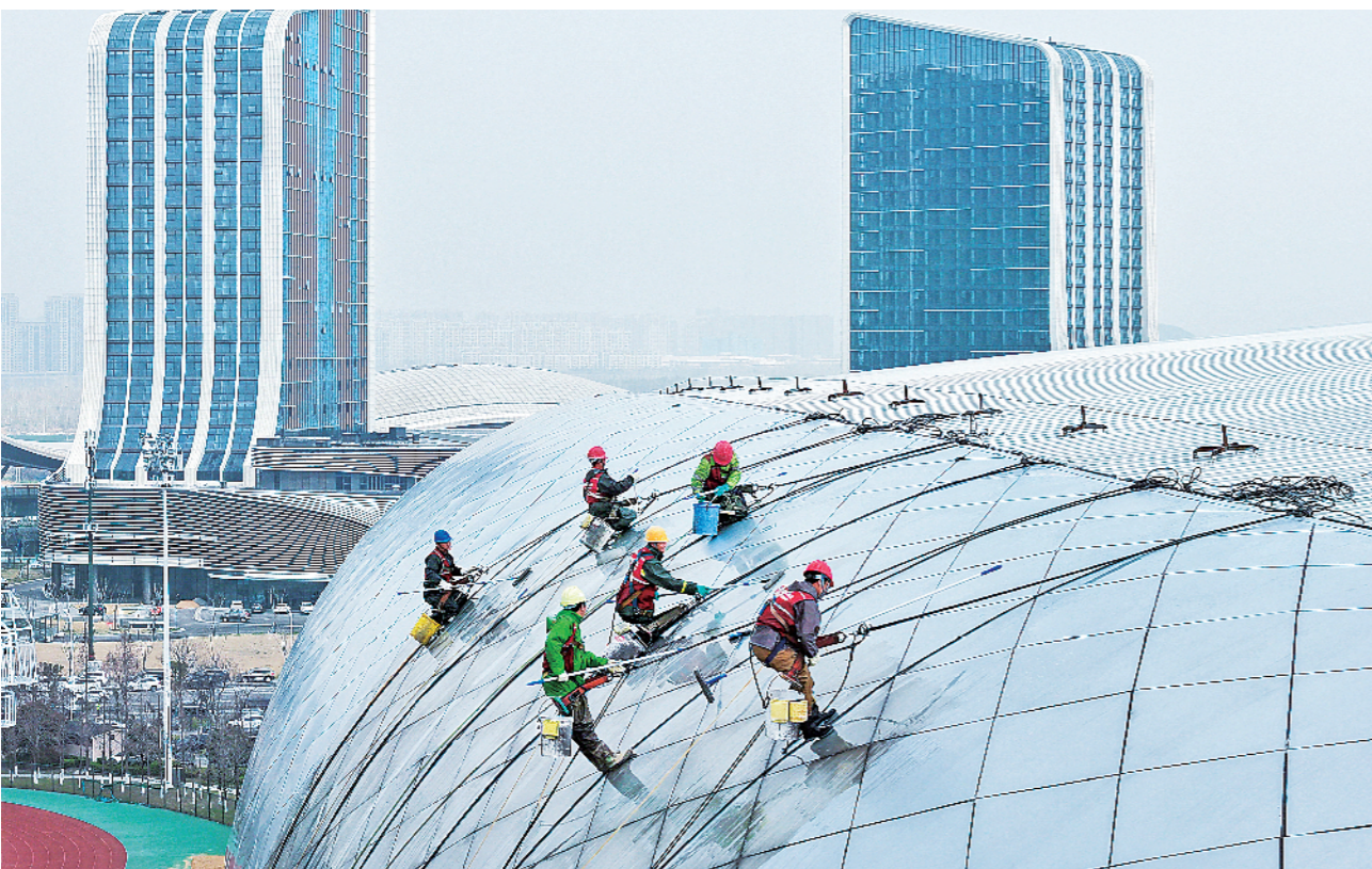
3月21日，徐州奥体中心“鸟巢”外立面清洗完成，银灰色菱形网格外立面焕然一新，以崭新的姿态迎接即将到来的“苏超”赛事。图为工人们在进行收尾工作。
