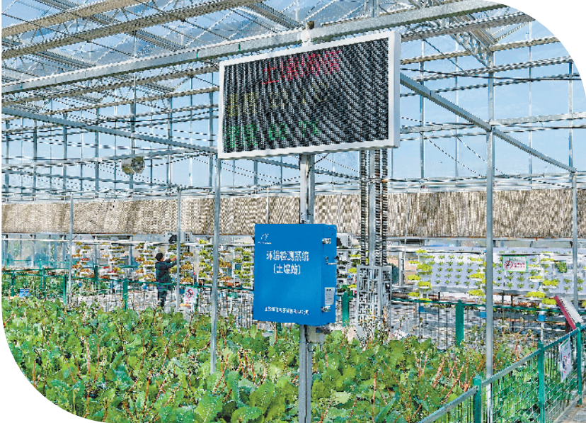
环境检测系统实时记录土壤的温度和湿度。
