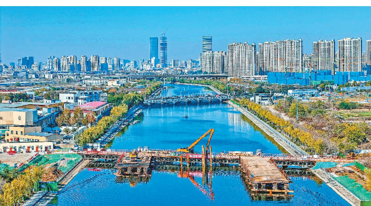
近日,金山东路东延项目中的1号桥及污水管迁改工程进入关键施工阶段。1号桥为新建市政桥梁,跨越黄河,桥宽50米,下部结构为柱式墩、群桩基础。同时,污水管迁改工程同步实施,通过雨污分流系统实现污水集中处理,助力城市生态治理。
