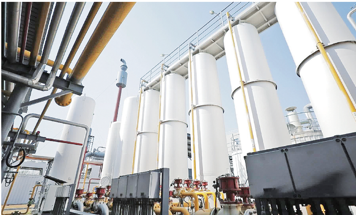
国新公司生物质燃气脱硫区设备。
