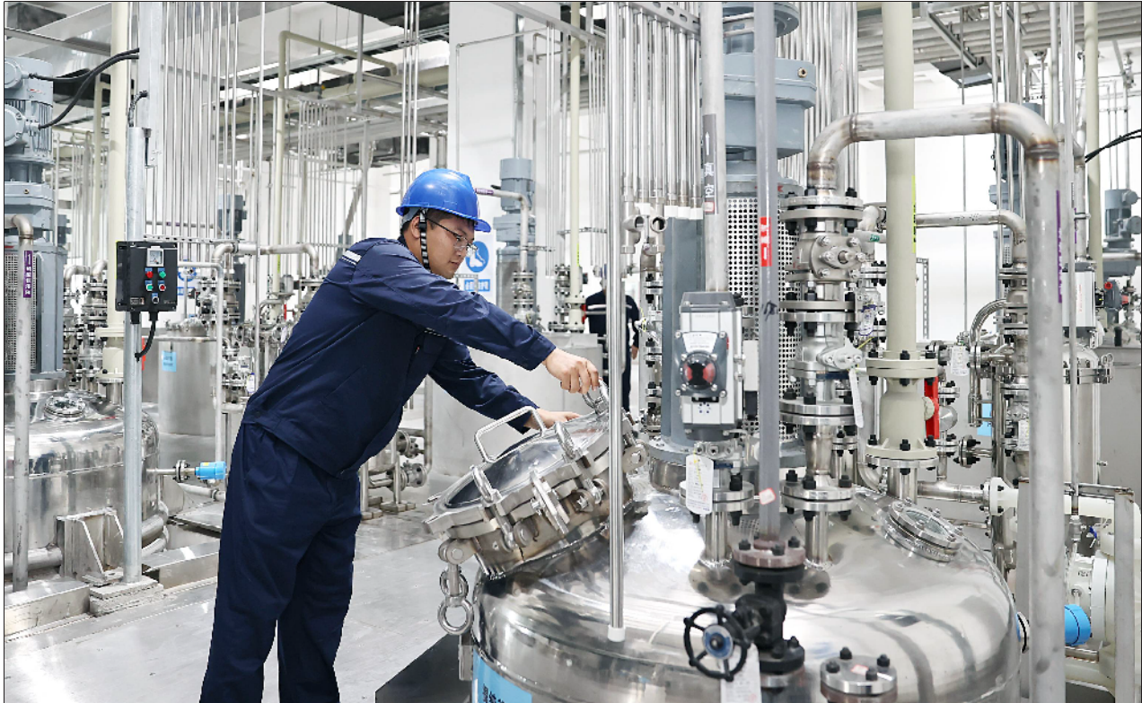
近日，在鸿脉新材料项目生产车间内，工人们正在紧张有序地忙碌着。作为市重大产业项目，该项目总投资30亿元，目前一期主体施工已经完成，部分生产线已投入生产。
