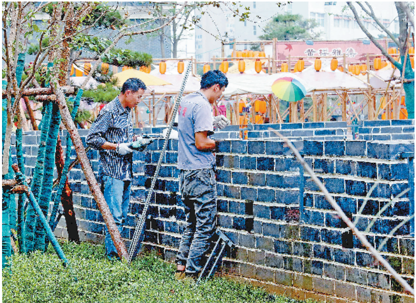
在黄楼公园,工人们正在进行修补作业。 本报记者 齐浩 摄
