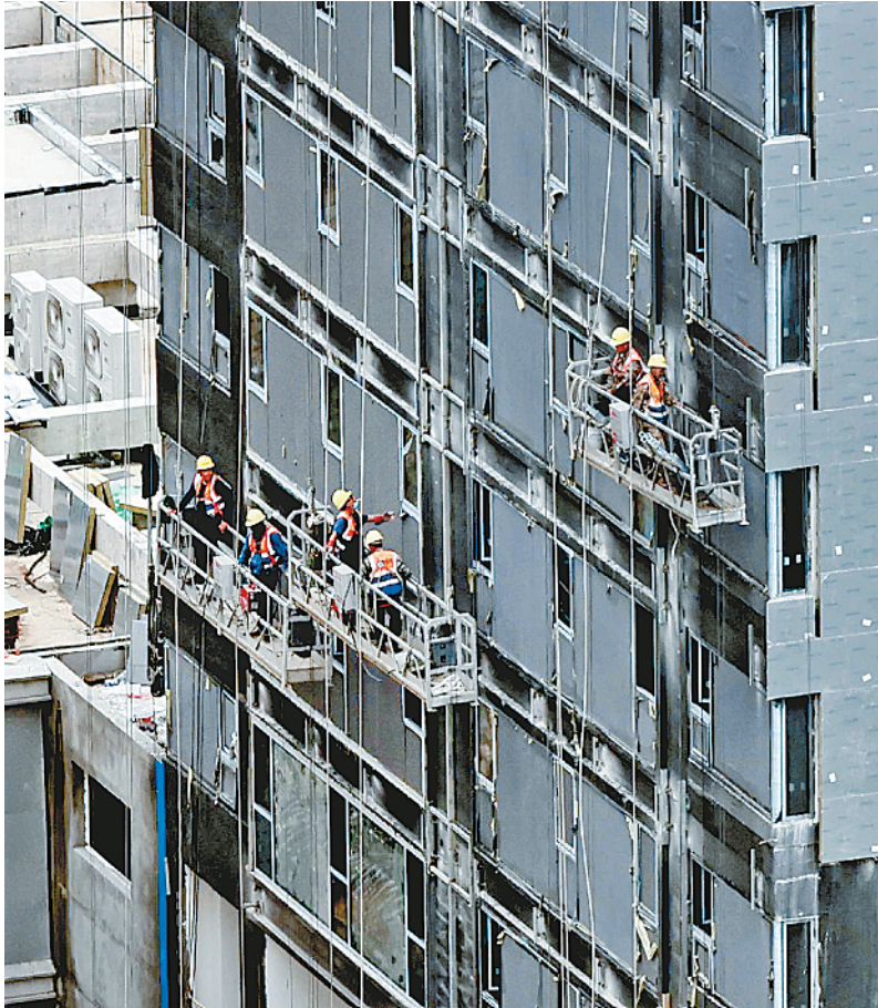
高空作业的建筑工人。 本报记者 齐浩 摄
