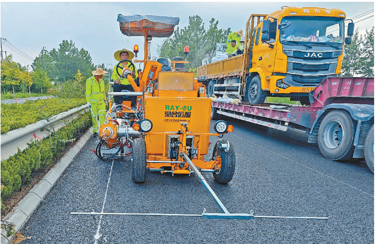
徐州市首台乘驾式热熔喷涂划线机在作业中。 市公路中心 供图
