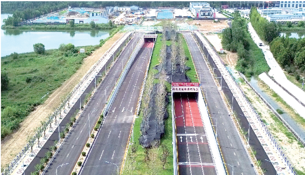
济南黄岗路黄河隧道通车，这是国内首条“穿黄”单洞双层盾构隧道。新华社记者 朱峥 摄
