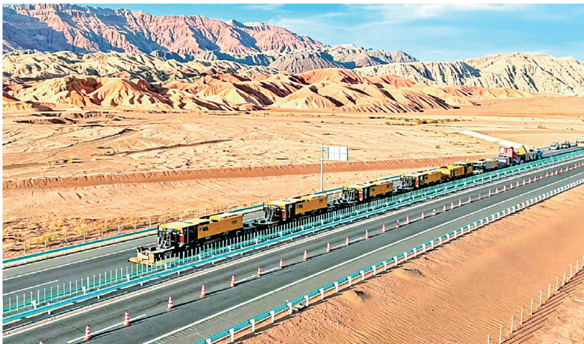
就地热再生成套设备在工程现场投入使用。
