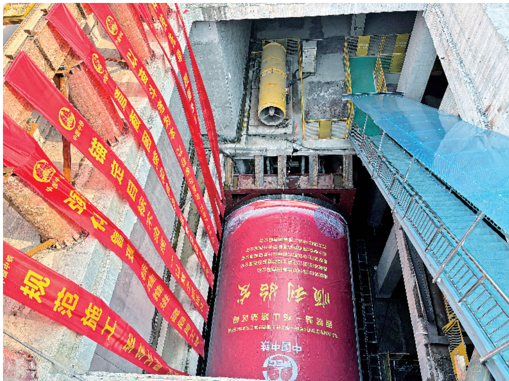
西贺站至杨山路站区间右线盾构机正式破土掘进。通讯员 田龙 摄
