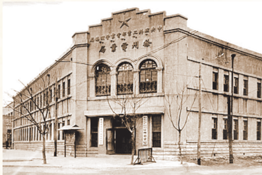
新中国成立初期的徐州电业局主楼。
