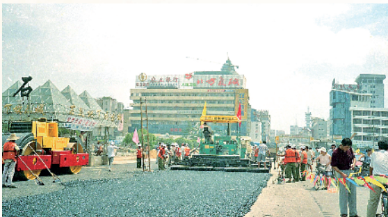
“三场一路”项目中，淮海路正在重新铺设。
