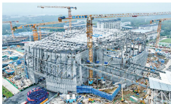
紧凑型聚变能实验装置(BEST)建设现场。
