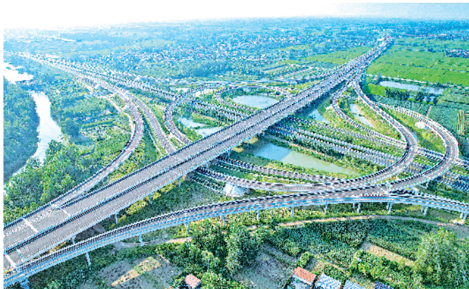
徐州东部绕越高速公路项目主体工程。该高速公路进一步巩固提升了徐州的全国综合交通枢纽地位。
