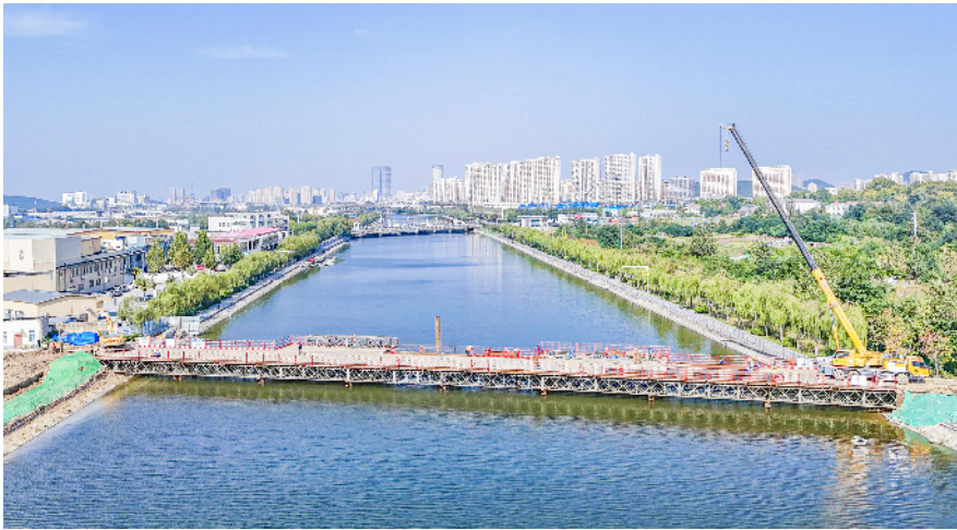
这条新建市政桥梁雏形已现
