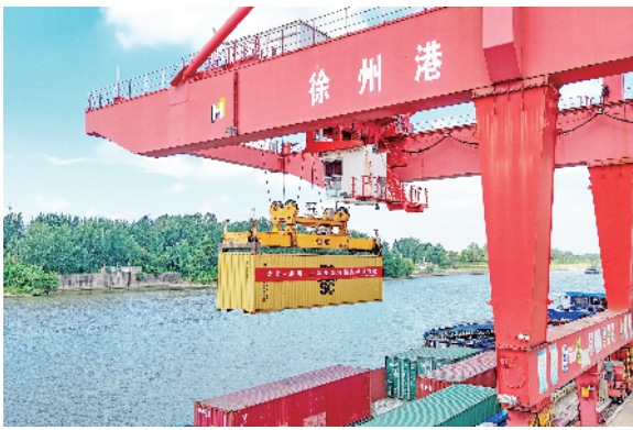
京杭大运河江苏徐州双楼港作业区宏康码头,大型起重设备正在进行集装箱装运作业。刘冰 摄
