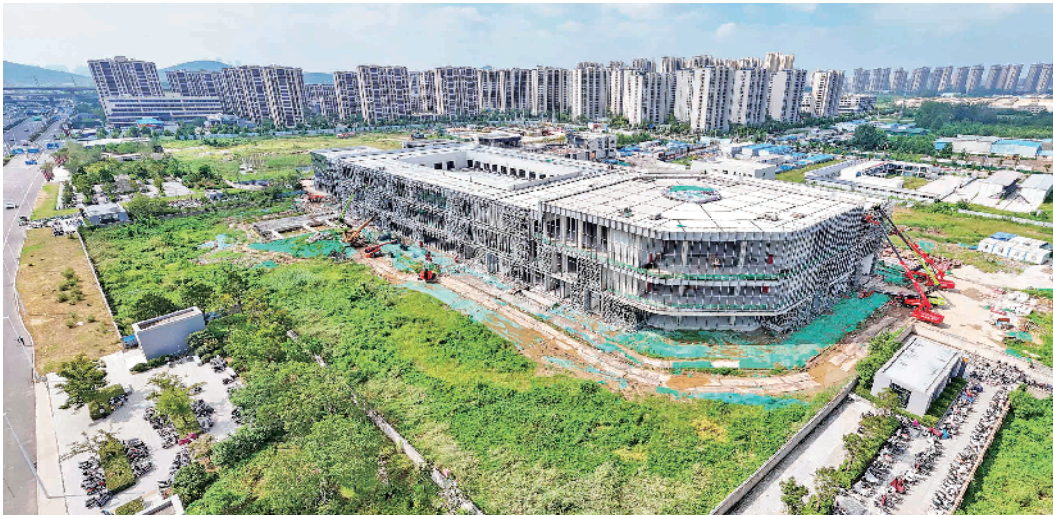
城北城市客运换乘中心项目正在进行外立面施工。
